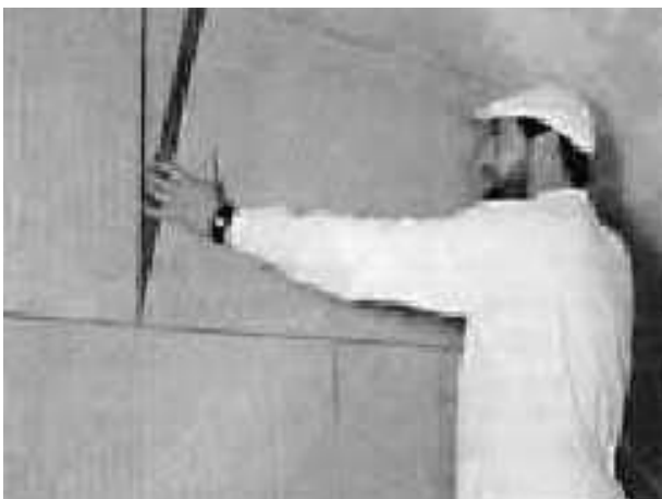
Innenputz-Dämmsystem aus Mineralfaserplatten ohne Dampfsperre
