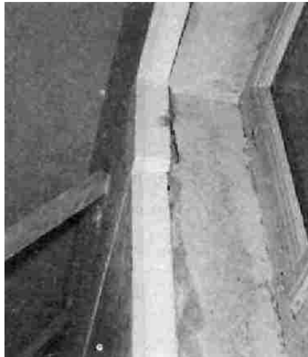
Verbundplatte aus Gipskarton und Dämmung mit Dampfsperre
