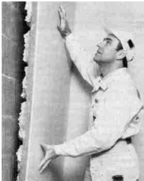
Anbringung einer Gipskarton-Verbundplatte mit Mineralfaserdämmung und Dampfsperre.
