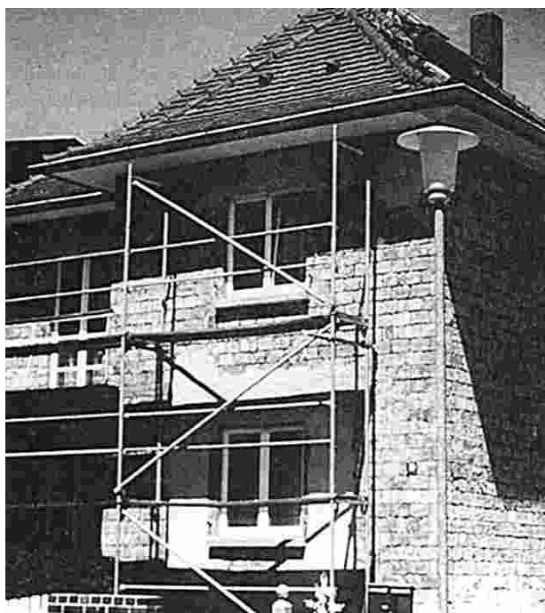
Putzerneruerung - der richtige Zeitpunkt für die Anbringung eines Wärmedämmverbundsystems.
