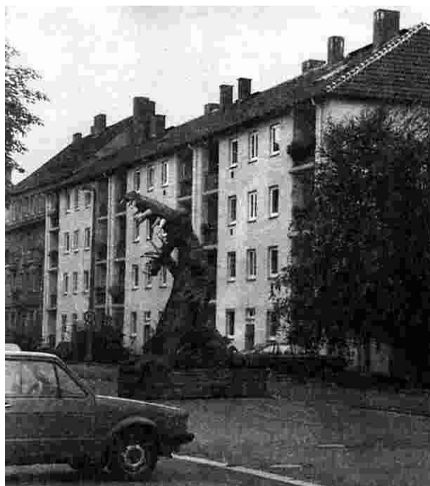
Diese Wohnhäuser wurden 1987 mit einer 8 cm starken Thermohaut und einer Kellerdeckendämmung ausgestattet. Die Energieeinsparung betrug in der ersten Heizperiode 47 %. Die Hessische Landesregierung empfiehlt mittlerweile eine ca. 12 cm starke Dämmschicht für bestehende Gebäude.
