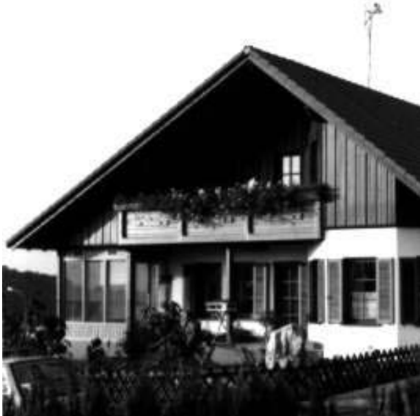
Dieses Niedrigenergiehaus im nordhessischen Schrecksbach verbraucht bei 168 m 2 Wohnfläche nur 1200 - Liter Heizöl pro Jahr. Eine 15 cm Starke Thermohaut gehört, u.a. zum Wärmeschutz des Gebäudes.
