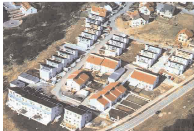
Niedrigenergie-Siedlung „Distelweg“, Niedernhausen
