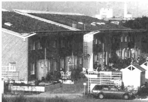
Eine kompakte Bauweise z.B. als Reihenhaus, wie bei diesen Niedrigenergiehäusern in Darmstadt-Kranichstein, minimiert die wärmeabgebende Außenoberfläche von Gebäuden.
