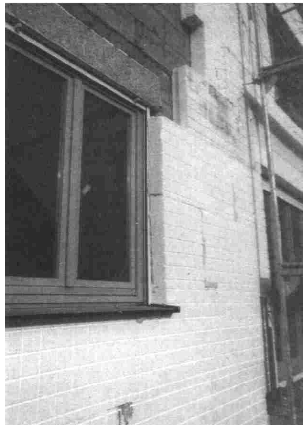
Zweischaliges Mauerwerk mit Kerndämmung
