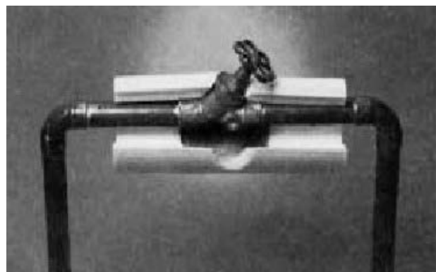
Dämmung einer Verteilleitung
