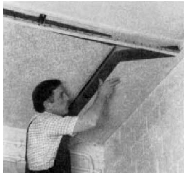
Kellerdeckendämmung
