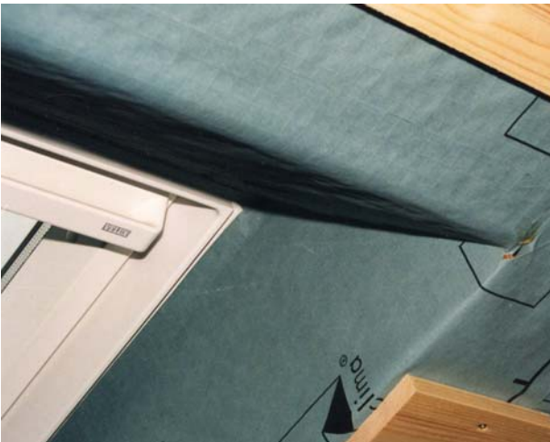
Bei herkömmlichen Dachflächenfenstern (ohne Formteil für die Laibung oder vormontierte Folienstreifen) muss die Dampfsperrefolie in die Nut des Blendrahmens eingeklebt werden.
