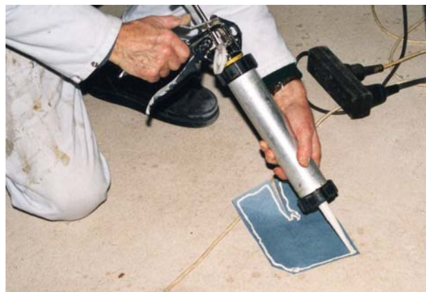
Dieser Flicker wird die leicht eingerissene Ecke an der Laibung des Dachfensters (s. Bild links) abdichten.
