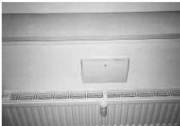
Abb. 10 a und b: Zuluftelemente im Fensterrahmen oder unterhalb der Fensterbank. Durch diese günstigen Anordnungsmöglichkeiten lassen sich die Geräte gut warten.
