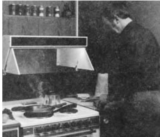
Abb. 9: Dunstabzugshaube, richtig angebracht
