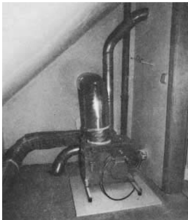
Abb. 2: Zentrales Ventilatorgerät mit 50 Watt Antriebsleistung, Abmessungen: Würfel mit ca. 30 cm Kantenlänge.
