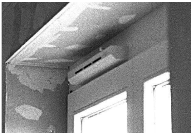
Abb. 10 a und b: Zuluftelemente im Fensterrahmen oder unterhalb der Fensterbank. Durch diese günstigen Anordnungsmöglichkeiten lassen sich die Geräte gut warten.
